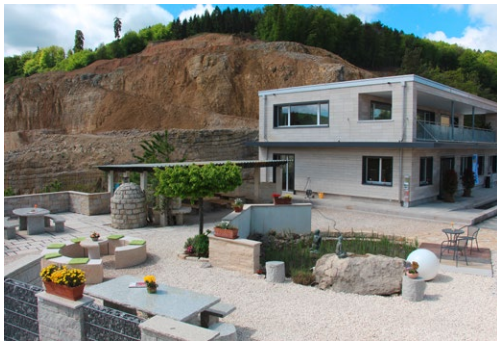
Neu erstelltes Empfangs- und Bürogebäude
